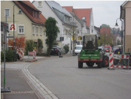
Baustelle der Fußgängerampel
